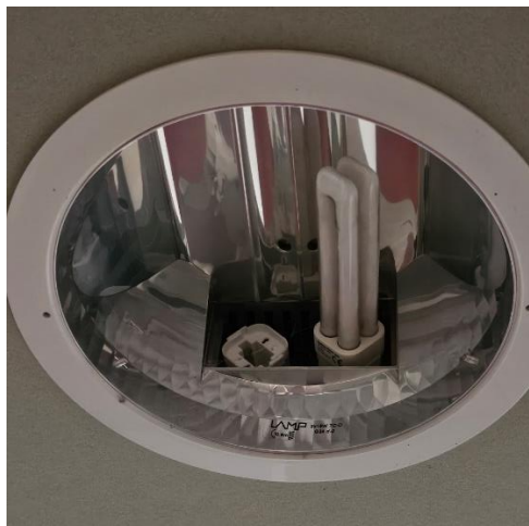
Figure 11: Couloir technicien / Détail
