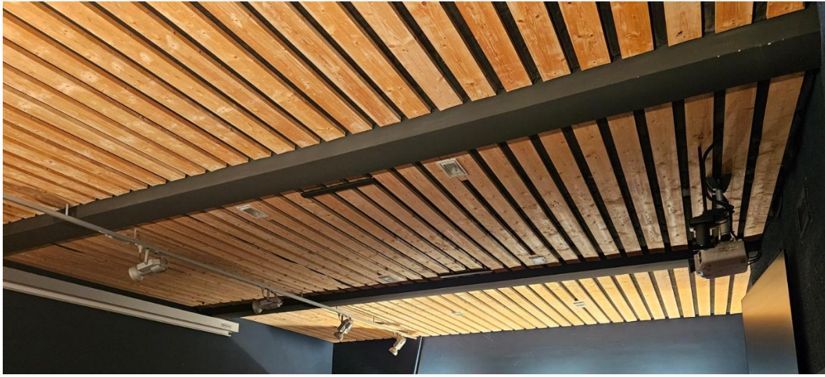
Figure 6: Salle de conférence, partie centrale
