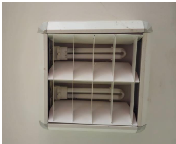
Figure 12: Applique plafond 2x36 w à remplacer
