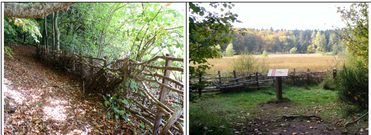
Barrières végétales installées en 2005
