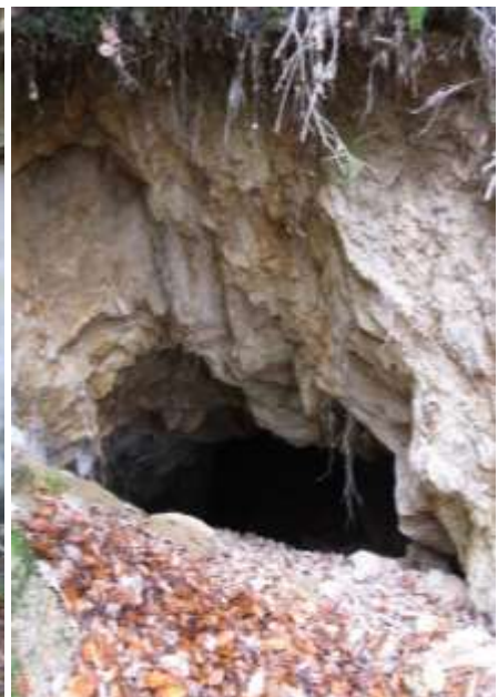
Ré-ouverture d'une galerie éboulée (© CEN Auvergne)
