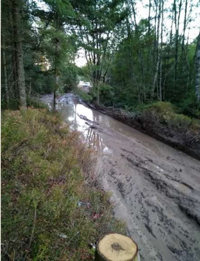
Piste forestière dégradée
